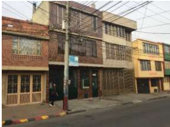
Fotografía No 3. Vista de los alrededores del predio.
